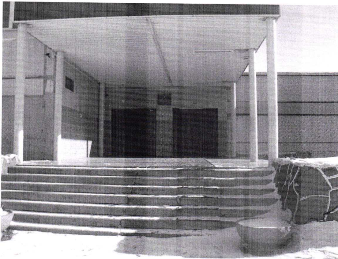
№6 Наружная лестница (центральная вход)
